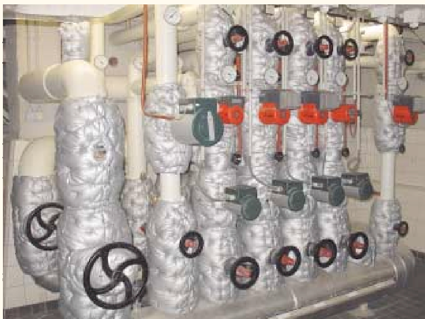
Tweehonderd vierkante meter isolatiematras in het Koninklijk Instituut voor de Tropen
